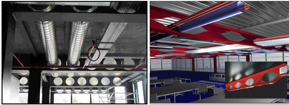
Şekil 9 Dairesel ve Sinüs gözlü petek kirişlerde servis bütünlüğü.
