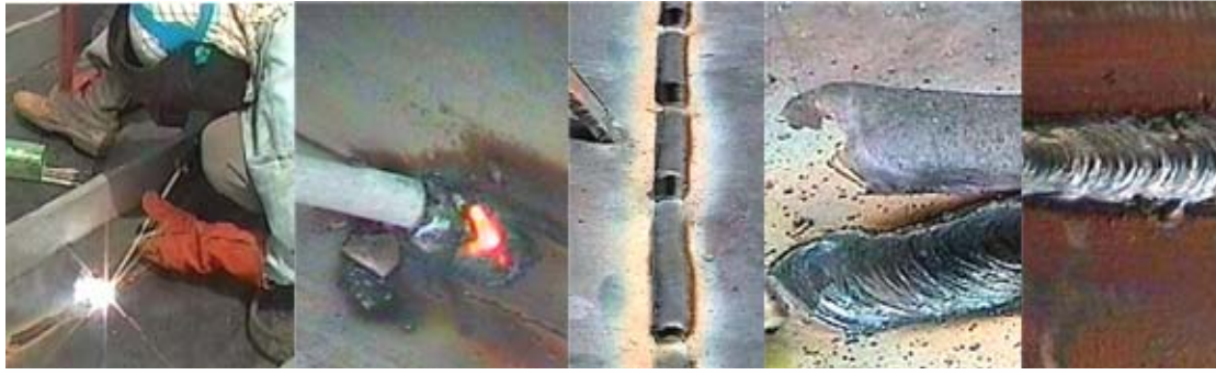
Resim 7. Elektrot kaynağı uygulaması
