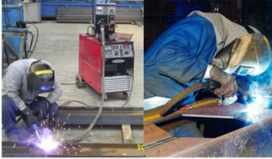
Resim 13. MIG Elektrik Ark kaynağı uygulaması
