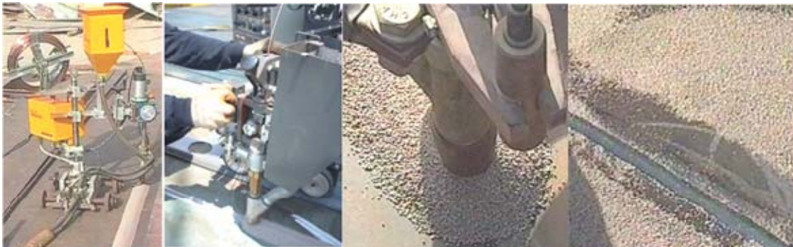
Resim 9. Kaynak bölgesinin üzerini örten özel toz malzemesi
