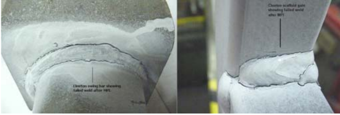
Resim 2. Kaynaklı birleşimlerde hasar oluşumları
