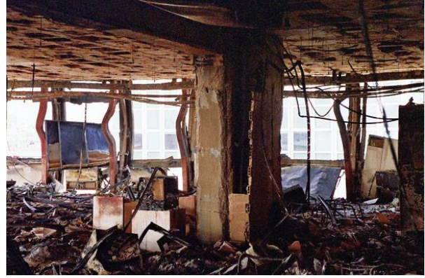
Resim 8-9. Korumasız çevresel çelik kolonların yangın sırasında burkulması (9. Kat)
