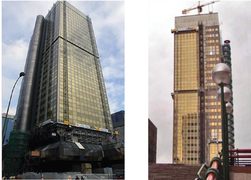
Resim 6-7. Windsor Tower binası / Cephe kuruluşları
