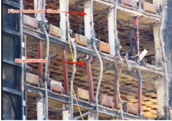
Resim 8-9. Korumasız çevresel çelik kolonların yangın sırasında burkulması (9. Kat)
