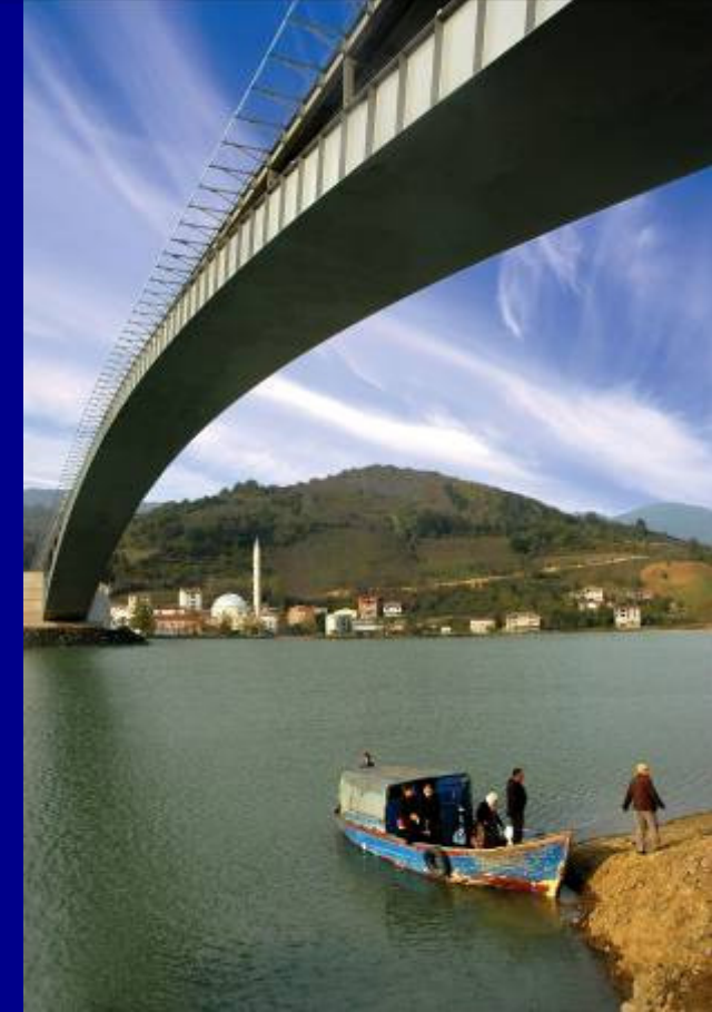
Samsun Ayvacık Baraj Köprüsü
